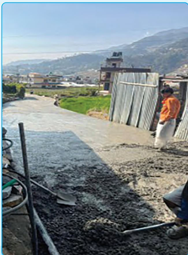
वडा नं १ पब्लिक बोर्डिङ स्कुलदेखि सेतुबन्ध सम्म जाने मोटरबाटो ढलान तथा बाल निर्माण
