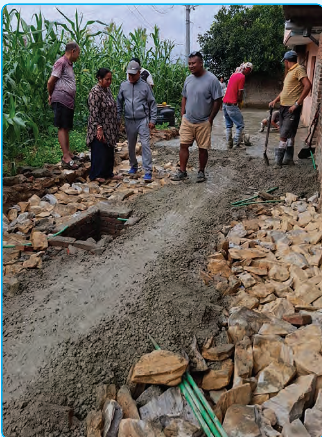
वडा नं ४ बाटो ढलान कार्य
