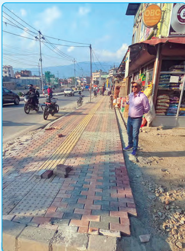
वडा नं ११ करिडोर सडकमा १० फिट्टे फुटपाथ निर्माण पछि ब्लक बिछ्याईदै
