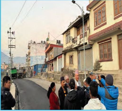
वडा नं. ८ स्थित साङ्लेखोला करिडोर सडक ओभरले
