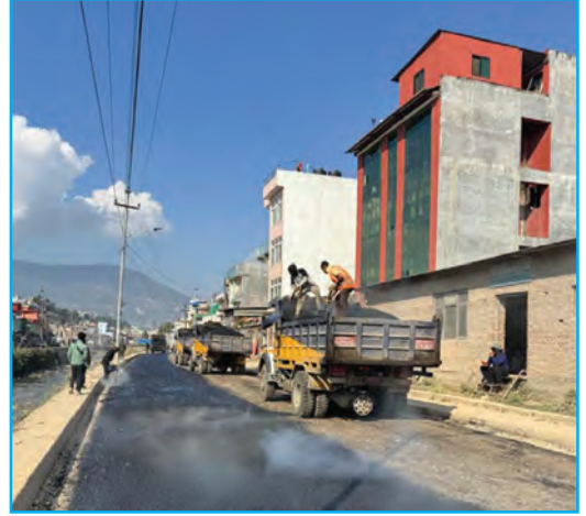
वडा नं. ८ स्थित साङ्लेखोला करिडोर सडक ओभरले
