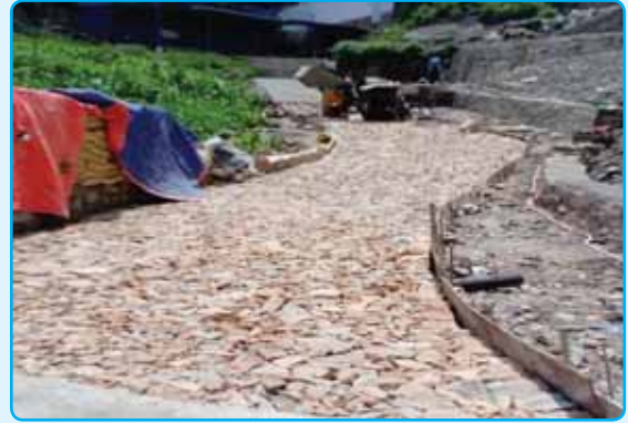
टोखा नगरपालिका वडा नं. ६ को दुङ्गेधारा जाने बाटो ढलान
