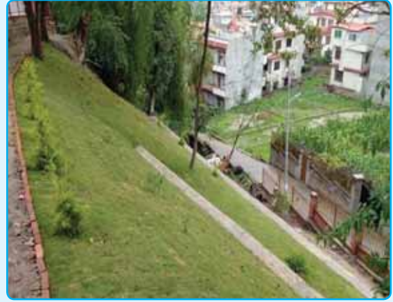
टोखा नगरपालिका वडा नं. ६ को लाखेडाँडा पार्क निर्माण
