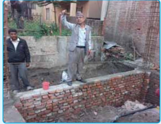
क्रियापुत्री भवन, वडा नं. ५
