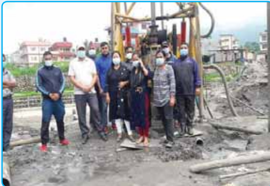
भत्केकोपुल धमलटार स्टारटाउन आसपास बस्तीको लागि खाने पानी डिप बोरीड
