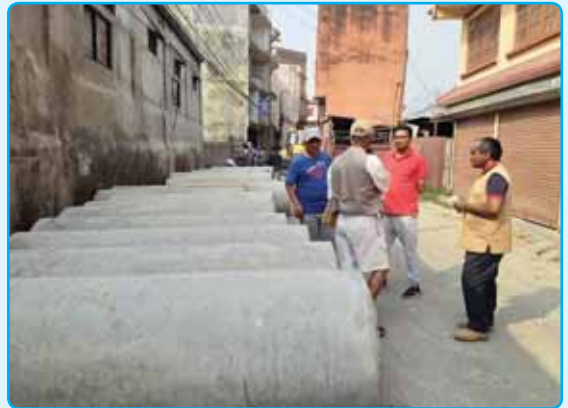
ढल निर्माण कार्यको लागि तयारी अवस्थामा वडा नं. ७
