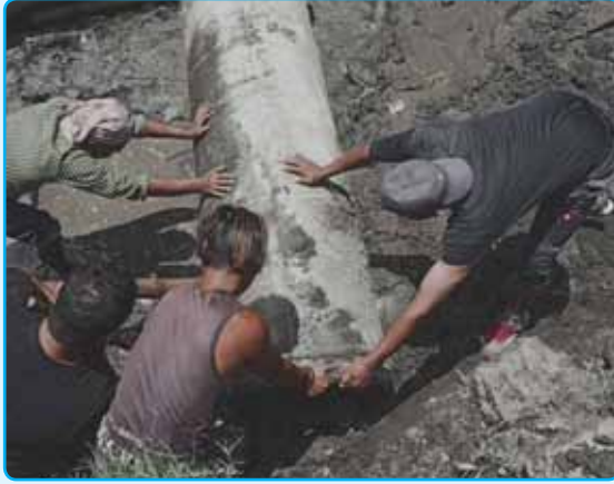
इको सडक तथा ढल निर्माण, वडा नं. २
