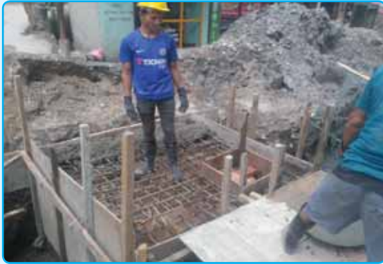
टोखा मैन रोडमा ढलको च्याम्बर निर्माण
