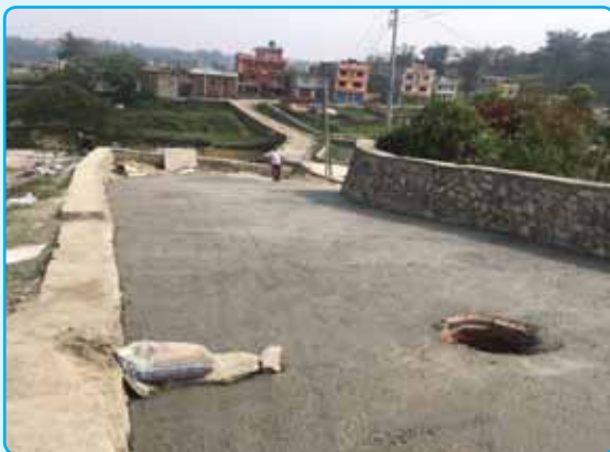
सकटा जाने पचा बाटो निर्माण, वडा नं. २
