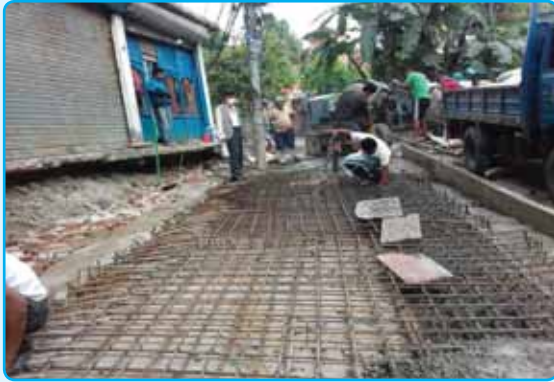
बाटो ढलान, वडा नं. ५
