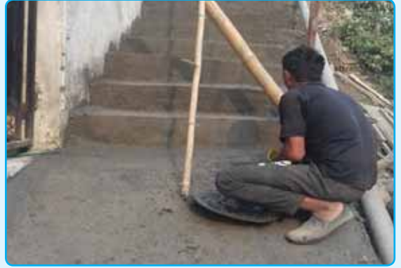
बासुकी मार्ग देखि धापासी चुनदेवी सिंढी निर्माण, वडा नं. ५
