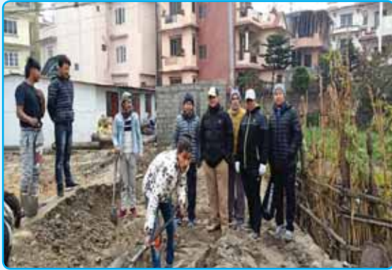
वडा नं. ८ मिलन टोलमा ढल निर्माणमा अनुगमन
