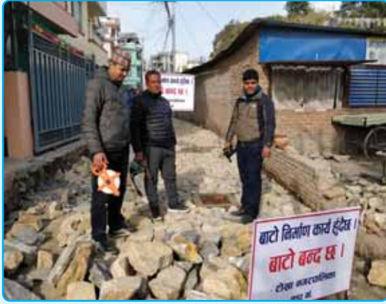
वडा नं. ५ मा बाटो निर्माण
