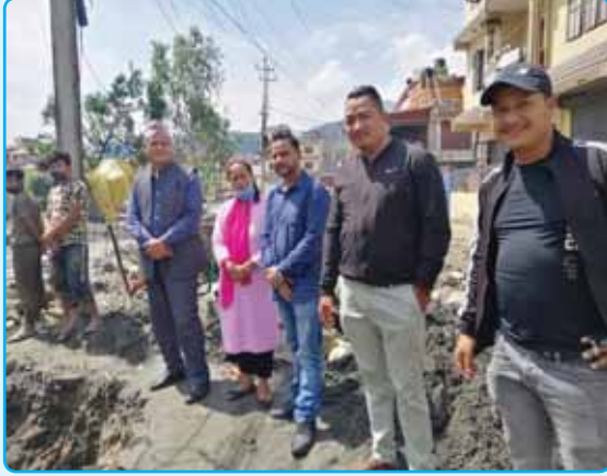
नगर प्रमुख विष्णुमती खोलाको किनारको पर्खाल अनुगमन
