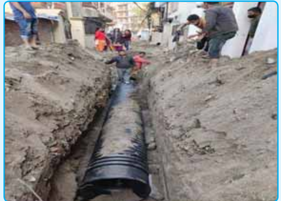
न्यू सुन्दर चोक ढल निर्माण, वडा नं. ८
