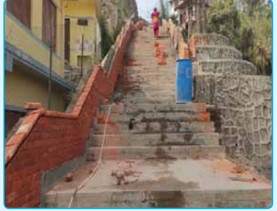
नास पाच सिंढी निर्माण, वडा नं. २
