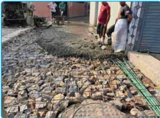
बिरञ्जरको घर देखी भुवनको घर सम्म बाटो ढलान, वडा नं. ३
