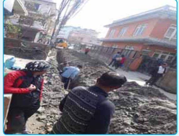
मिलन टोलमा ढल निर्माण कार्य वडा नं. ८
