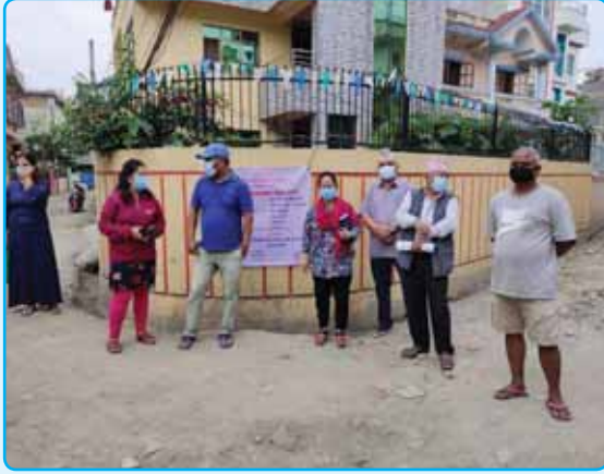
न्यू सुन्दर चोक ढल निर्माण, वडा नं. ८
