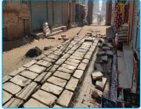
टोखा मूल सडक ढुंगा छाप्ने कार्य
