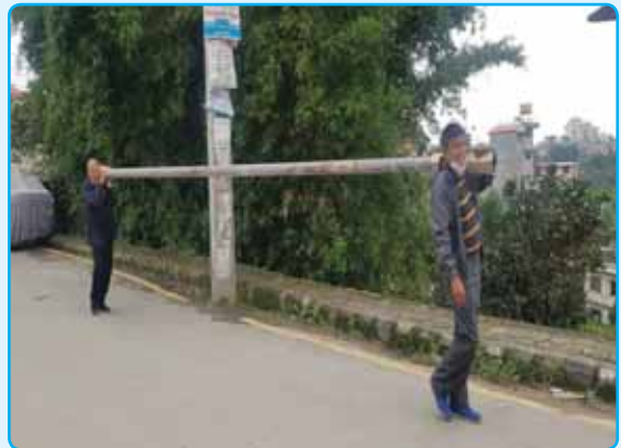
खानेपानी पाइपलाइन व्यवस्थापनमा आफै खटिनु भएका वडा नं. ४ का जनप्रतिनिधिहरु
