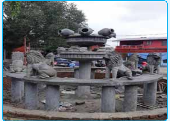
निर्माणाधीन कल्की पार्क
