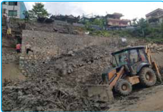
निर्माणाधिन लाम्पाखा पार्क, वडा नं. ४
