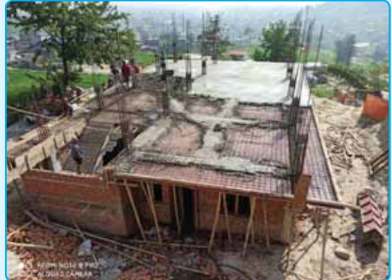
ओम शान्ति भवन निर्माणको चरणमा, वडा नं. १
