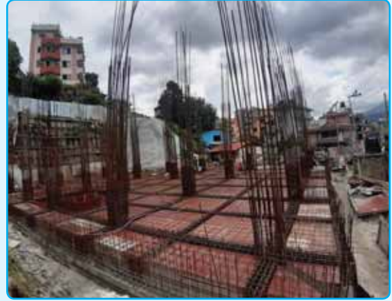
टोखा नगरपालिकाको निर्माणाधिन भवन
