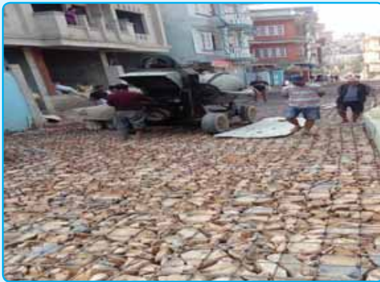
हरियाली वस्ती सडक निर्माण, वडा नं. ६
