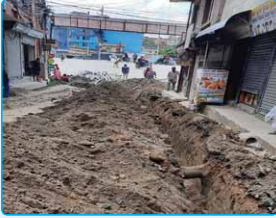
दिपक महर्जनको घर देखि लिला भुजेलको घर सम्म पाइपलाइन वितरण वडा नं ७
