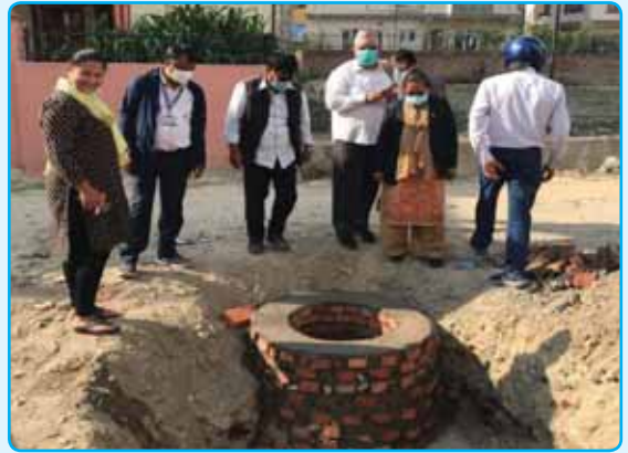
भुडोल ढल निर्माण अनुगमन, वडा नं. ३
