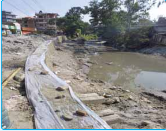
वडा नं. ८ र ११ को सिमानामा पर्खाल निर्माण
