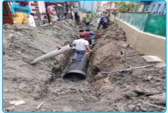
न्यू सुन्दर टोल ढल निर्माण
