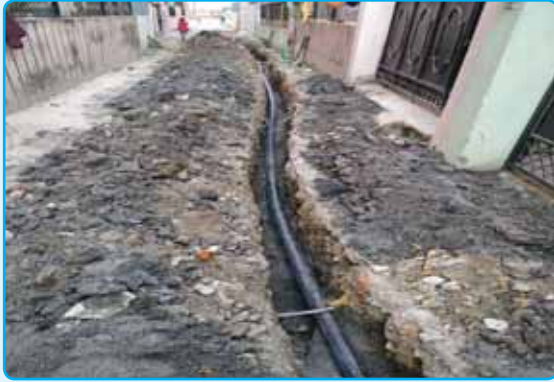
नमस्ते टोल पाइपलाइन कार्य तयारी, वडा नं. ८
