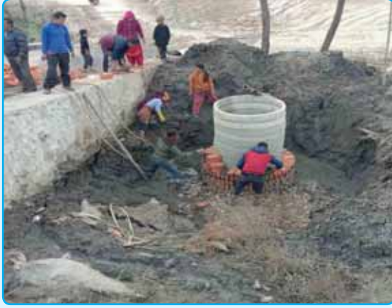
भुडोल ढल निर्माण, वडा नं. ३
