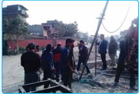
पुल निर्माणको लागि soil test
