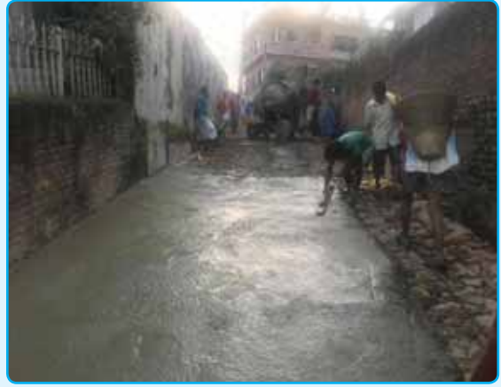
वडा नं. १० को बाटो ढलान कार्य
