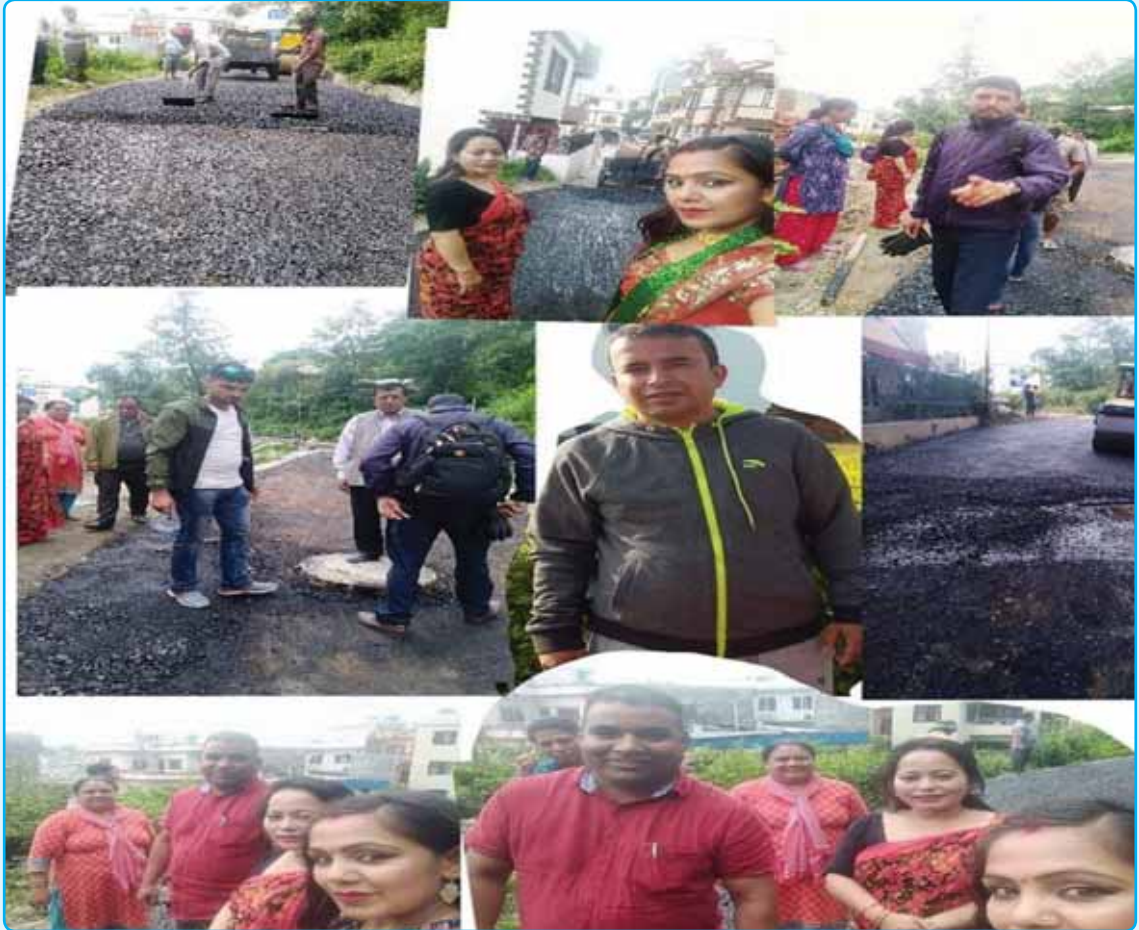
श्री स्वस्थानी बासुकी टोल सडक निर्माण, वडा नं ८
