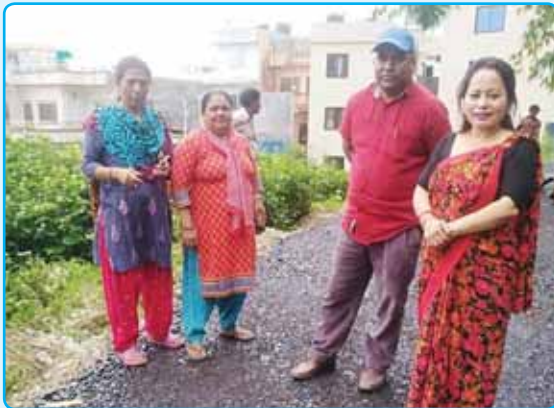
श्री स्वस्थानी बासुकी टोल सडक निर्माण, वडा नं.. ८
