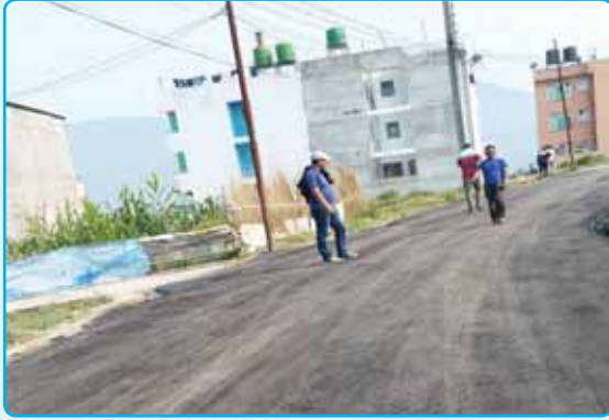
मेघा सिटी बाटो निर्माण कार्य, वडा नं.-३
