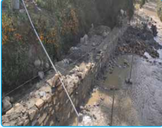
सानला खोला पुल संरक्षण
