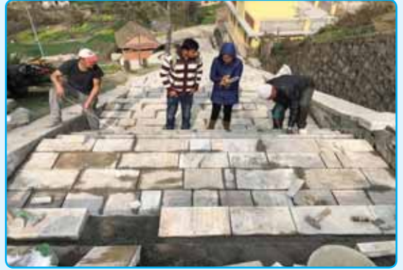
नासा-पाचा सिंढी निर्माण, वडा नं. २
