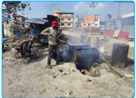
वडा नं. ८ बानियाटार पुलसंगैको बाटो पिच कार्य तयारी
