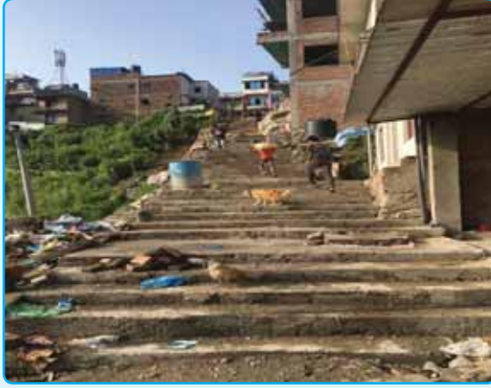
टोखा गले भुक्तानी सिंढी निर्माण, वडा नं. २
