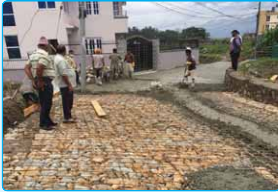
साईबाबा विष्णुमती सडक ढलान तयारी, वडा नं. ३
