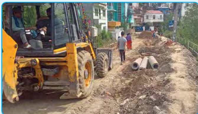
रेसुञ्जा कोलोनी देखि हेलाली जाने चोक बाटो सम्म ढल, खानेपानी पाइपलाइन बिस्तार वडा नं ४
