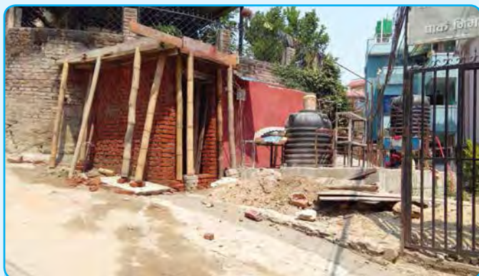
धापासी गणेश पार्कमा खानेपानी ट्याङ्की, शौचालय निर्माण र पानी रिचार्ज पुनर्भरण वडा नं ४
