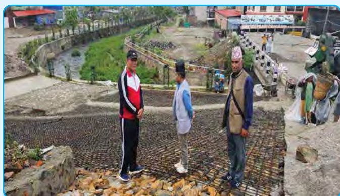
करिडोर सडक विस्तार तथा निर्माण वडा नं. ११ (अहिले)
