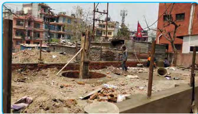
वडाको निरिक्षेण र निगरानीमा काठमाडौँ उपत्यका विकास प्राधिकरणमार्फत भाले पार्क निर्माण कार्य र टोखा नगरपालिकाको लगानीमा कोसेली घर समेत निर्माण हुने
