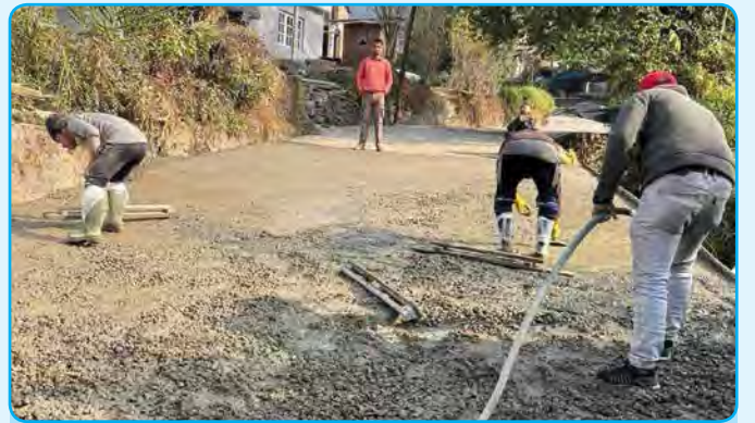
बौडेश्वर मा बि देखि भन्डारे सम्मको मोटर बाटो फराकिलो तथा वाल ड्रेन निमाण कार्य वडा नं १
