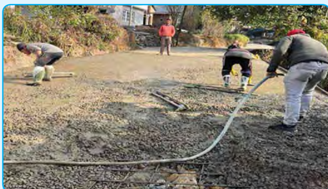
बौडेश्वर मा बि देखि भन्डारे सम्मको मोटर बाटो फराकिलो तथा वाल ट्रेन निर्माण कार्य
