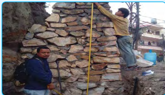
लामपाखा पार्कमा रिटेनीङ्ग वाल निर्माण तथा बाटो ढलान
