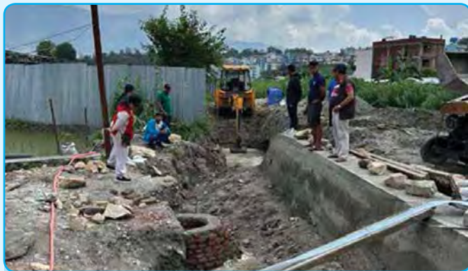
विष्णुमति करिडोर वाल निर्माण कार्य
