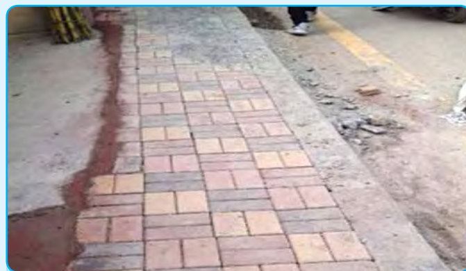
अल नेपाल हस्पिटल अगाडी मूल सडक दायाँ-बायाँ फुटपाथ निर्माण
