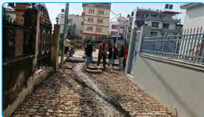
चर टोल को भित्रि बाटो ढलान कार्य वडा नं ३
