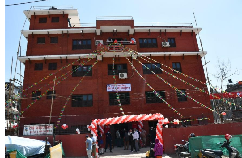
वडा नं. ९ को प्रशासनिक भवन निर्माण
