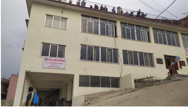
वडा नं. ११ को प्रशासनिक भवन निर्माण
