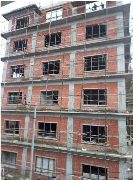
नगरपालिकाको प्रशासनिक भवन निर्माणको अन्तिम चरणमा
